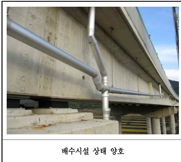
【사진 8.3.22】 배수시설 손상현황
