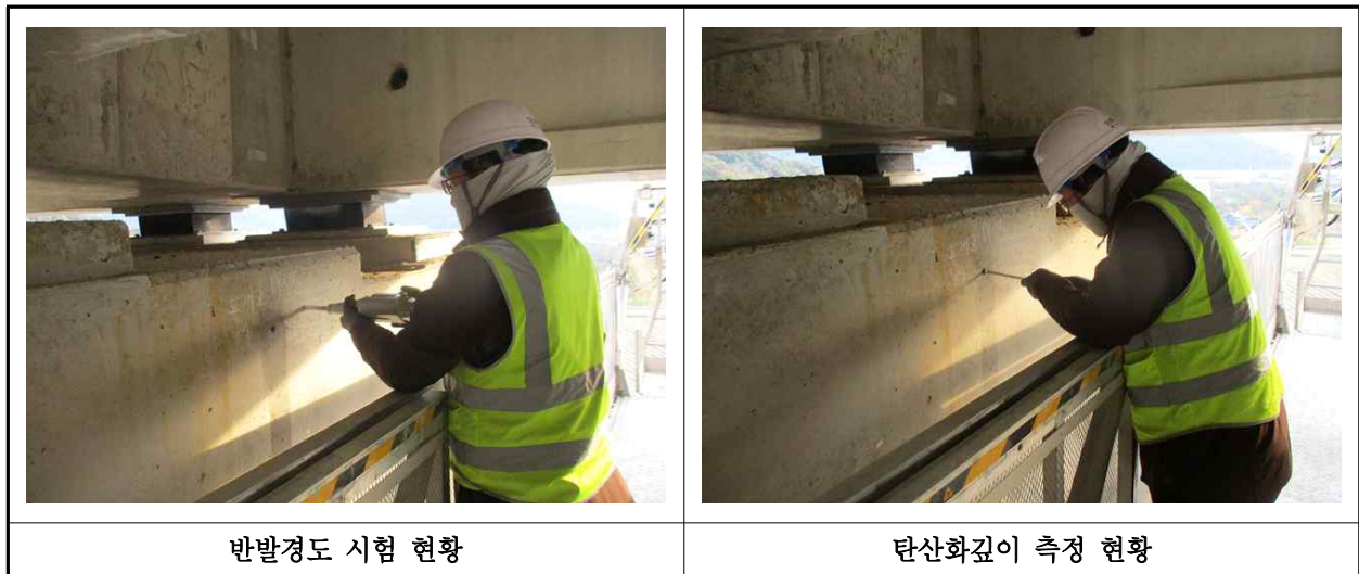
【사진 8.4.1】 콘크리트 내구성조사 현황
