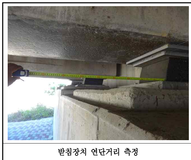
【사진 8.3.14】 교량받침장치 연단거리측정
