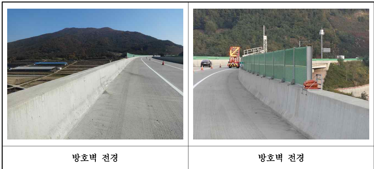
【사진 8.3.23】 방호벽 및 중앙분리대 전경
