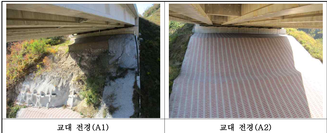
【사진 8.3.8】 교대 전경
