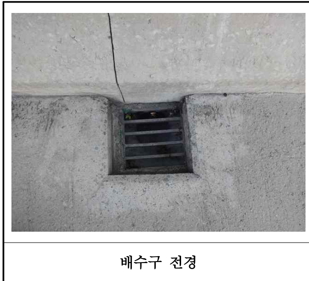
【사진 8.3.21】 배수시설 전경
