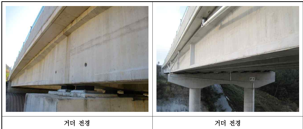
【사진 8.3.4】 거더 전경
