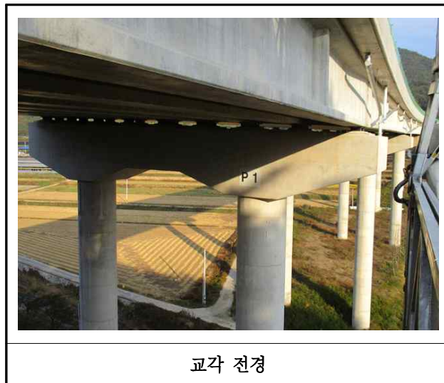
【사진 8.3.10】 교각 전경
