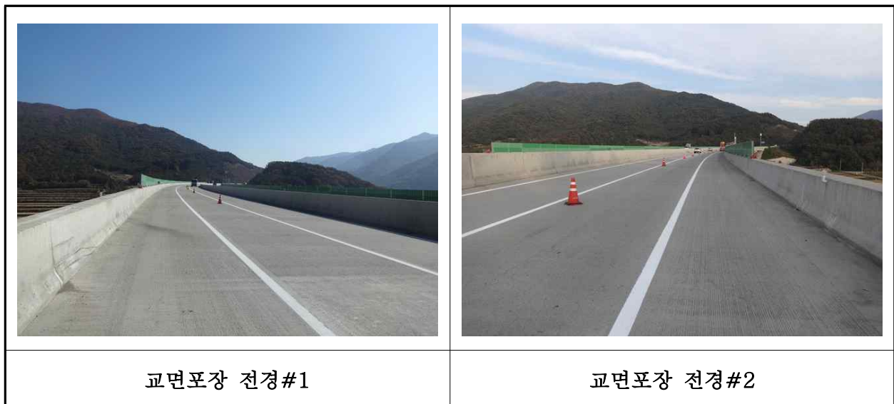
【사진 8.3.19】 교면포장 전경
